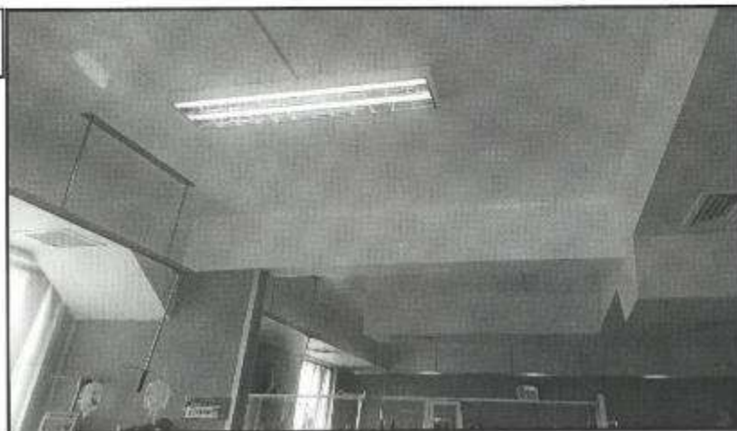
VISTA DEL CIELO RASO EL CUAL ESTA COMPUESTO TAMBIEN POR VIGAS PERALTADAS DE ALBAÑILERÍA Y DE TABIQUERÍA DRYWALL. LOS CUALES SERÁN PINTADAS CON PINTURA EPÓXICA.
