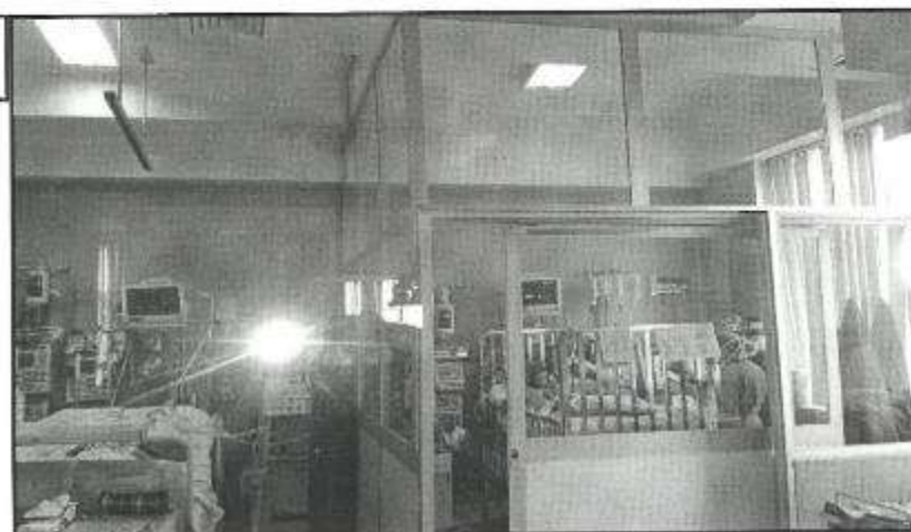
IMAGEN DE LA MAMPARA A DESMONTAR AL INICIO DE LOS TRABAJOS PARA REALIZAR EL CAMBIO DE PISO VINILICO Y POSTERIORMENTE REALIZAR EL MONTAJE DE LA MISMA.
